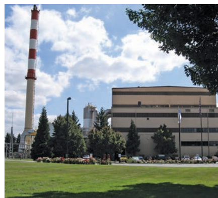
Instalación de generación de energía a partir de desechos en el condado de Marion
